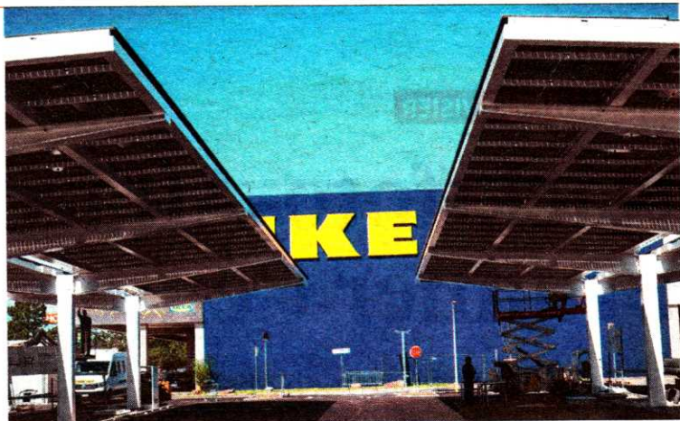
▲ Ein zentrales Element der Neugestaltung ist der neue Carport mit integrierter Photovoltaikanlage. Foto: Niklas Stadler
