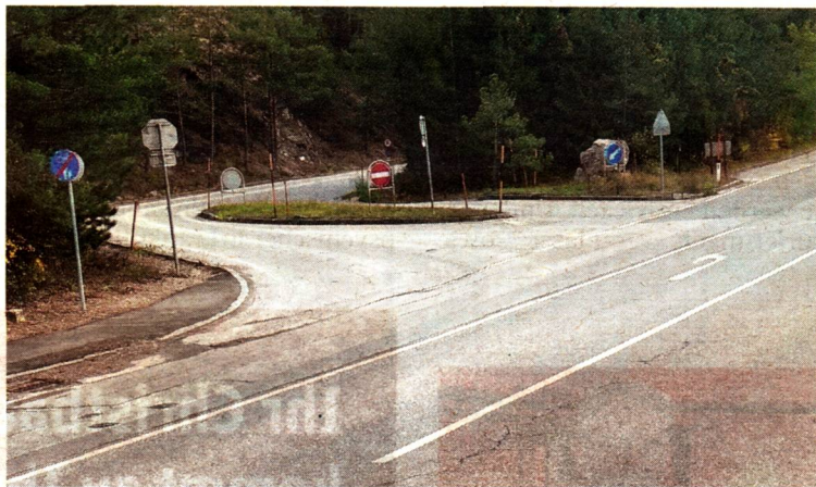
▲ B11 – Einfahrt Richtung Kerschgraben, Ende des Geh- und Radweges: die Kreuzung soll sicherer werden. Foto: privat
