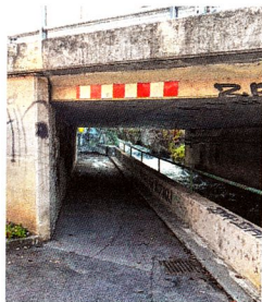
Die aktuelle Unterführung der Mödlingerstraße.
