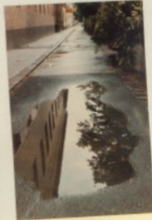
Radwege werden bei weitem nicht so sorgfältig gebaut wie Straßen. Erreichend: Der Bauamt behält teilweise Schwachstellen, die von DINAMo aufgezeigt werden.
