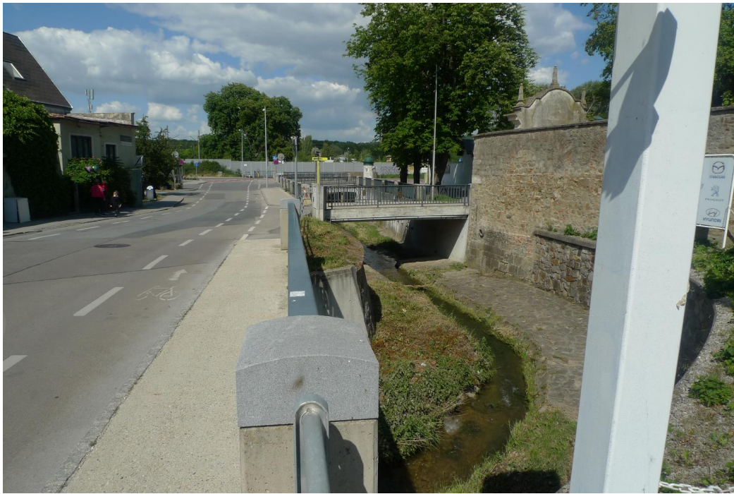
Abbildung 16: Kierlingbach bei Wiener Straße, Blick nach Osten
