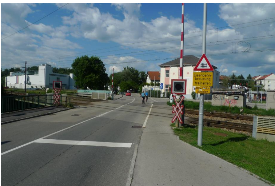
Abbildung 48: Bahnüberfahrt beim Essl-Museum
