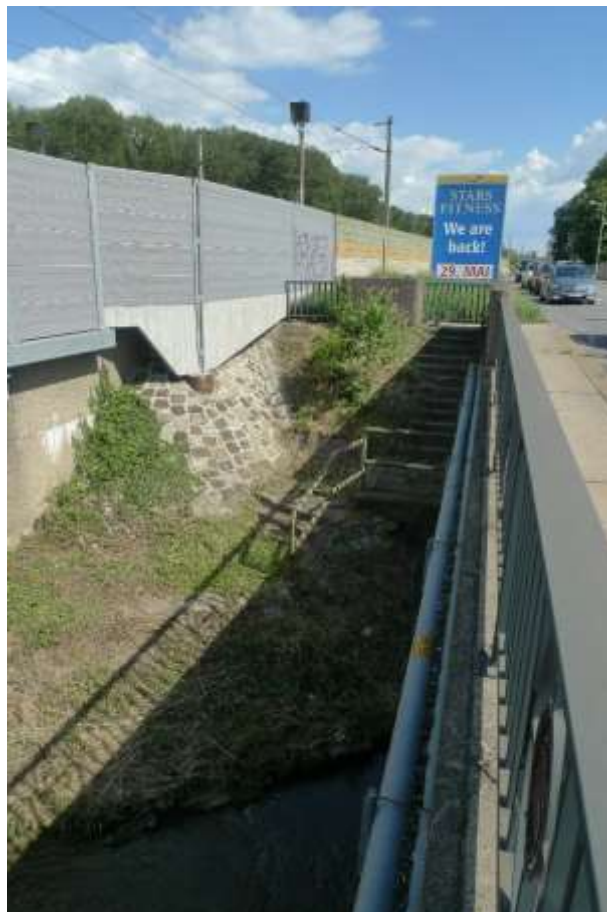
Abbildung 17: Bei der Brücke Wiener Straße / Kierlingbach ist ausreichend Platz für eine Rampe. Blick nach Süden.
