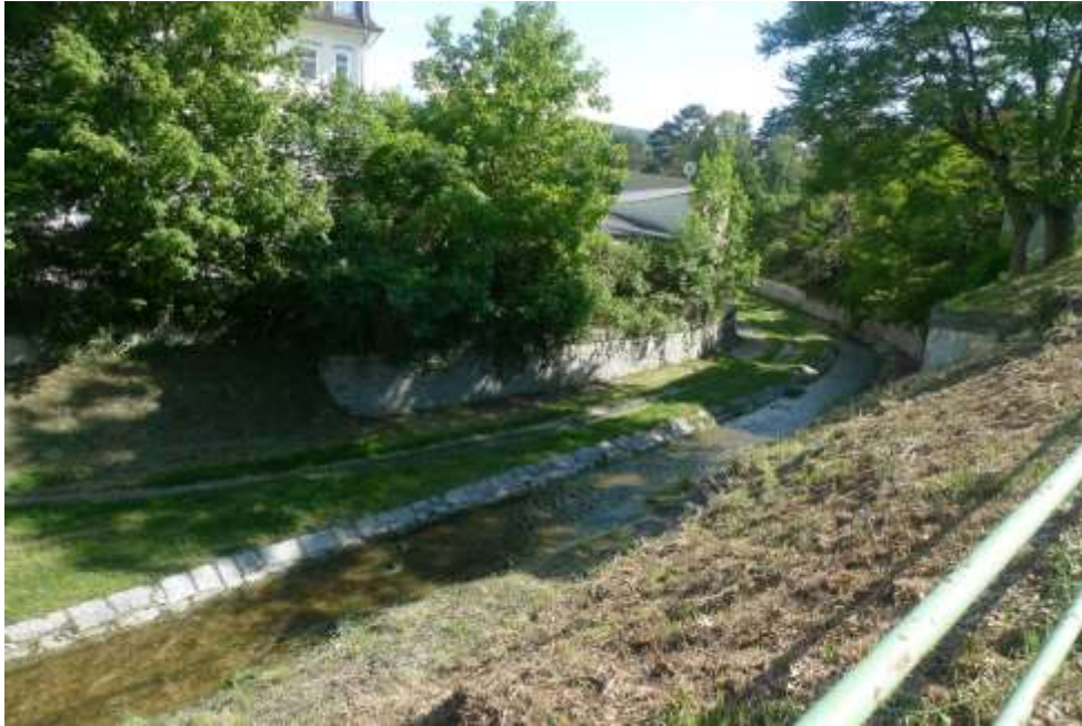
Abbildung 33: Weidlingbach kurz vor Wienerstraße, Blick nach Westen
