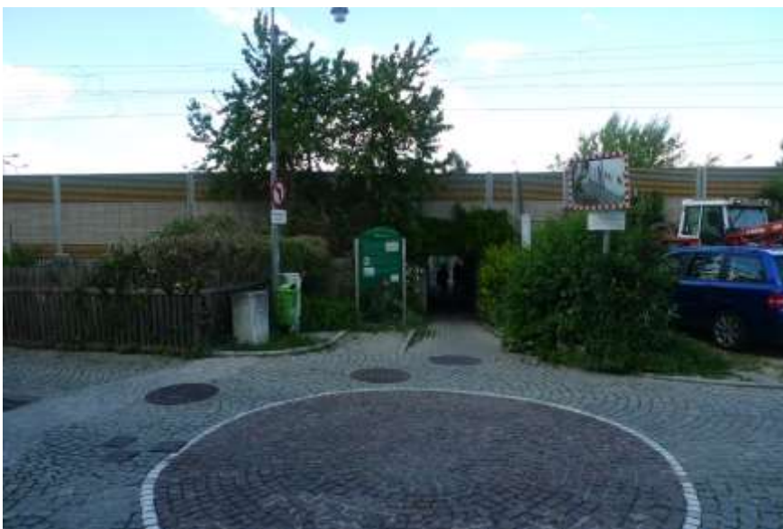
Abbildung 14: Bahnunterführung Wasserzeile/Höhe Fischergasse
