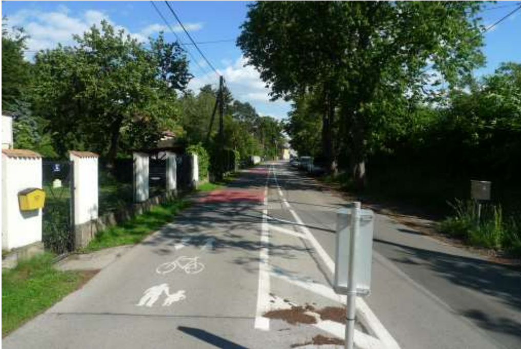
Abbildung 50: Donaustraße, Blick nach Süden
