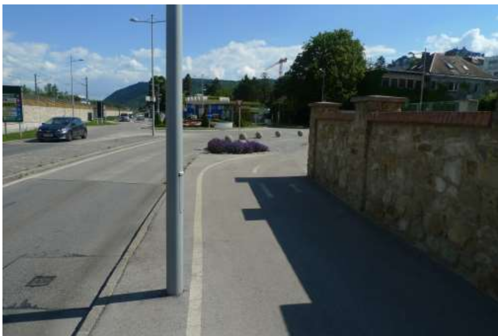
Abbildung 45: Kreisverkehr beim Stift, Blick nach Süden
