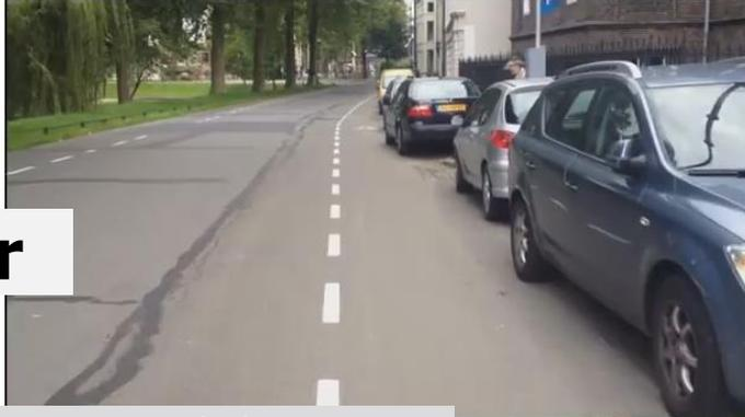
Nach den holländischen Richtlinien – Fahrbahn-Querschnitt mit 6,50m Breite wird so aufgeteilt: 2,00m breite, in rotem Asphalt ausgeführte Radstreifen auf beiden Seiten der Fahrbahn, mittige 2,50m schmale „Kernfahrbahn“.
