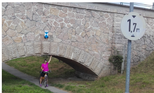
Abbildung 17: Unterführung Ufergasse / Wegscheider-Straße
