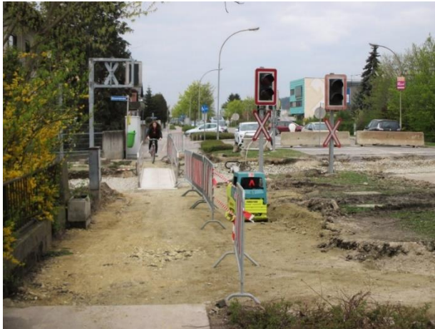
Während der Bauarbeiten konnte bereits freier geradelt werden, als zuvor mit den Absperrbügeln
