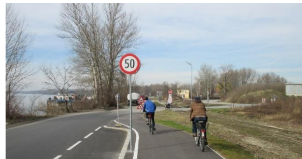
In einer Fahrtrichtung ist der neue Geh-/Radweg benutzungspflichtig. Hier endet er, sowohl FußgängerInnen als auch RadlerInnen müssen danach auf die Fahrbahn. Ab hier gilt Tempo 50, davor, im getrennten Bereich, gilt Tempo 30 – vielleicht kann dies einmal wer erklären, auf welcher sachlichen Grundlage diese Tempolimits verordnet wurden!
